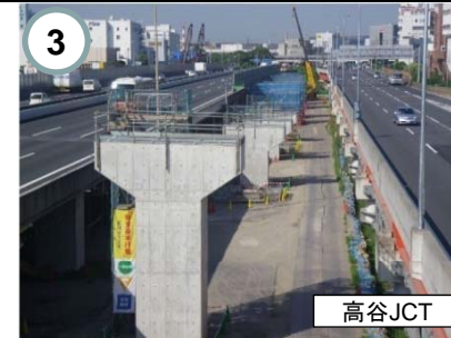
3 高谷JCT 下部工完成状況
