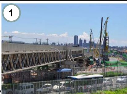
1 工所用仮橋と矢板打設状況
