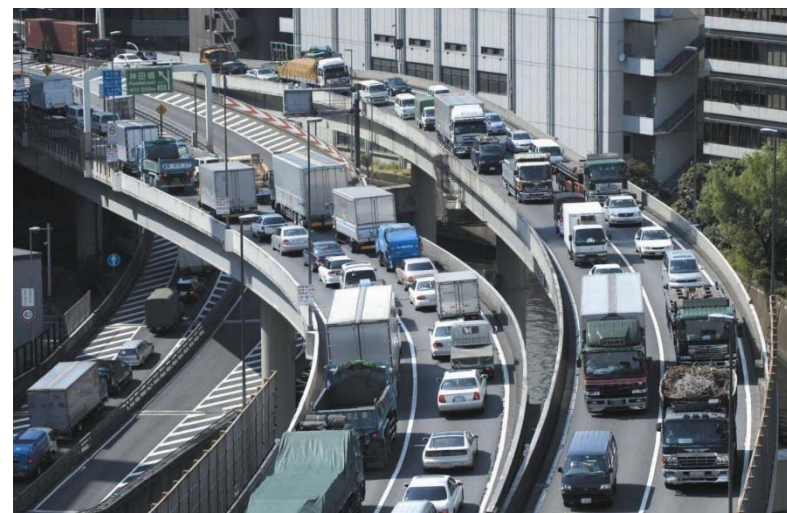
首都高速道路神田橋 JCT 付近
