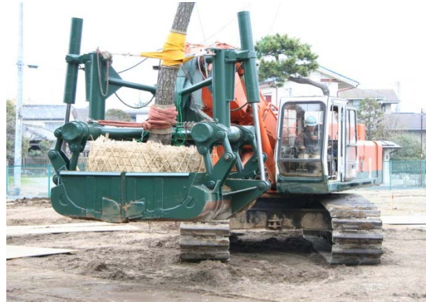
移植用重機による運搬
